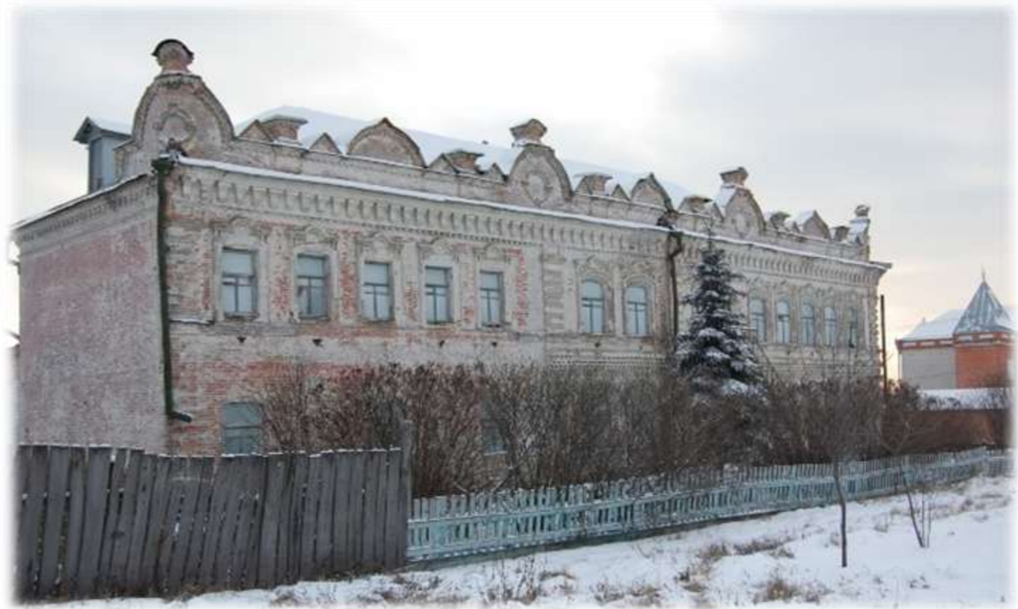
Строительство паломнического центра
